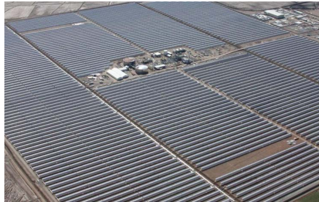
ANDASOL Granada : 7h SET 2 réservoirs de sels fondus : 28 000 tonnes
