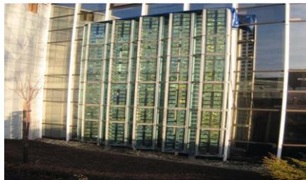
Figure 2 : Prototype photovoltaïque-thermique de configuration double-peau naturellement ventilée, installée au site de HBS-Technal, Toulouse (projet RESSOURCES)
