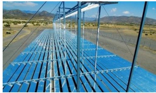
Figure 2 : Collecteur à miroirs linéaires de Fresnel (source : Fraunhofer)
