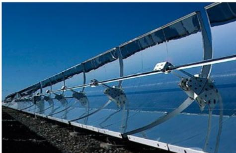
Figure 1 : Collecteur à miroirs cylindro-paraboliques
