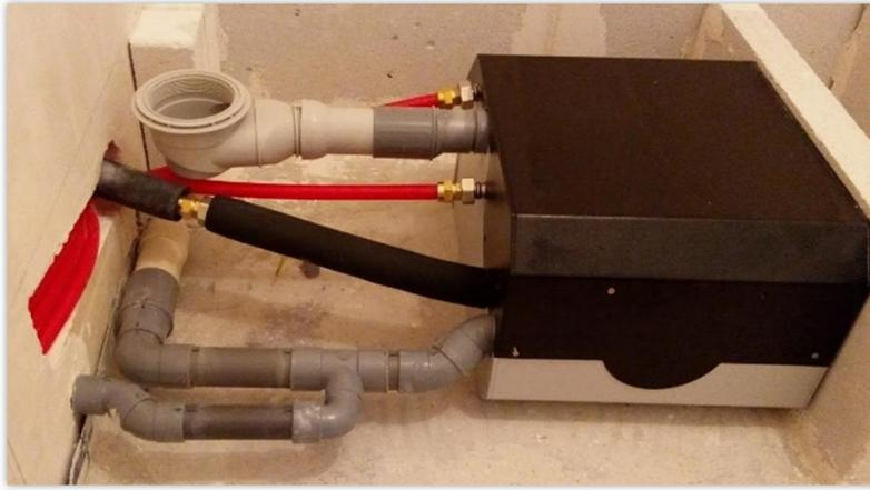
Figure 4 : Récupérateur de chaleur avec double raccordement
