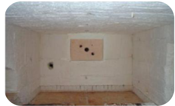
Vue interne du four
