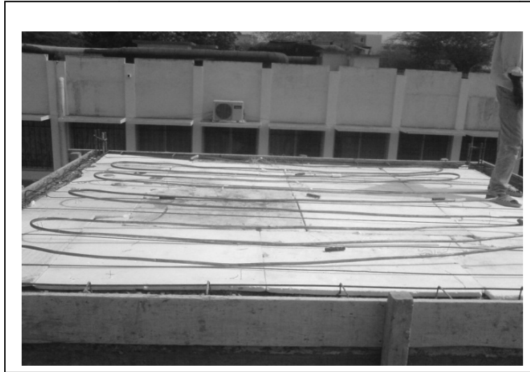
Figure 1 : Photo de la dalle avant coulage
