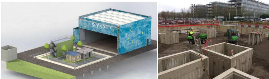
Figure 2 : Représentation de Sense-City et construction de la fosse géothermique
