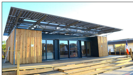
Figure 1 : Plateforme expérimentale Sumbiosi (vue façade Sud)
