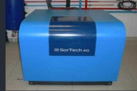
La machine comprend deux compartiments contenant un adsorbant solide (silica-gel), un évaporateur et un condenseur.
