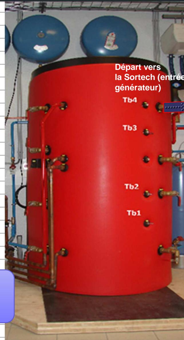
Fonctionnement de la Sortech :  $75^{\circ}\text{C} < \text{Tb4} < 94^{\circ}\text{C}$
