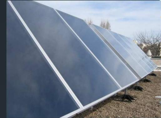
16 panneaux SunWin d'une surface d'absorbeur de 2,2m<sup>2</sup> unitaire soit une surface totale de 35.2m<sup>2</sup>.
