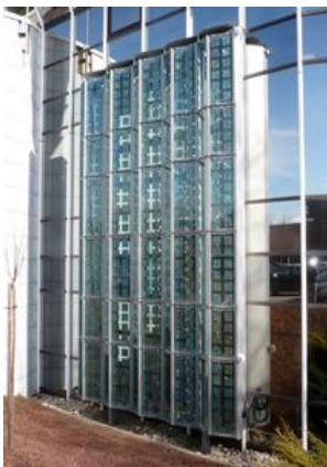
Figure 1 : prototype de double-peau PV plissée implanté sur une façade d'immeuble de bureaux HBS
