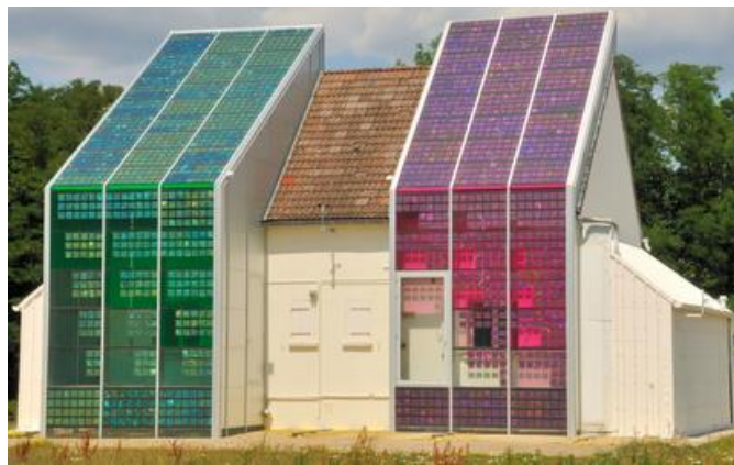
Figure 2 : prototypes de double-peaux PV sur maisons individuelles. Maisons jumelles ETNA d'EDF R&D. Gauche: ETNA B. Droite: ETNA A.
